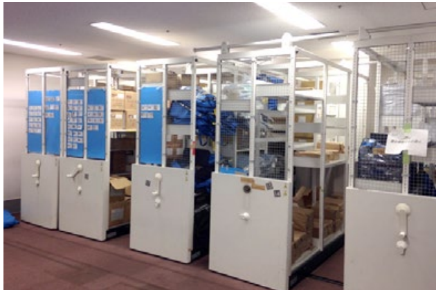
羽田空港第3ターミナルスタンバイエリア(元物品庫)改修前
